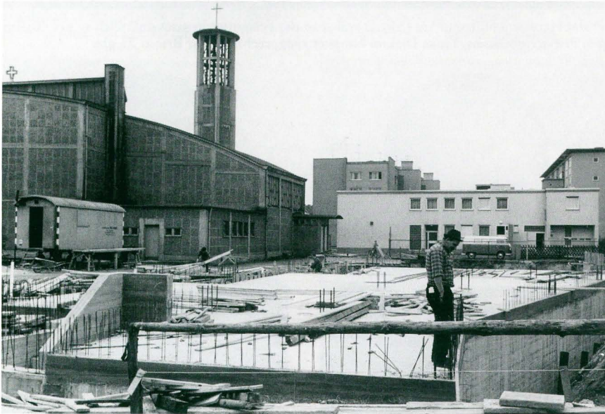
Der Kindergarten im Bau
